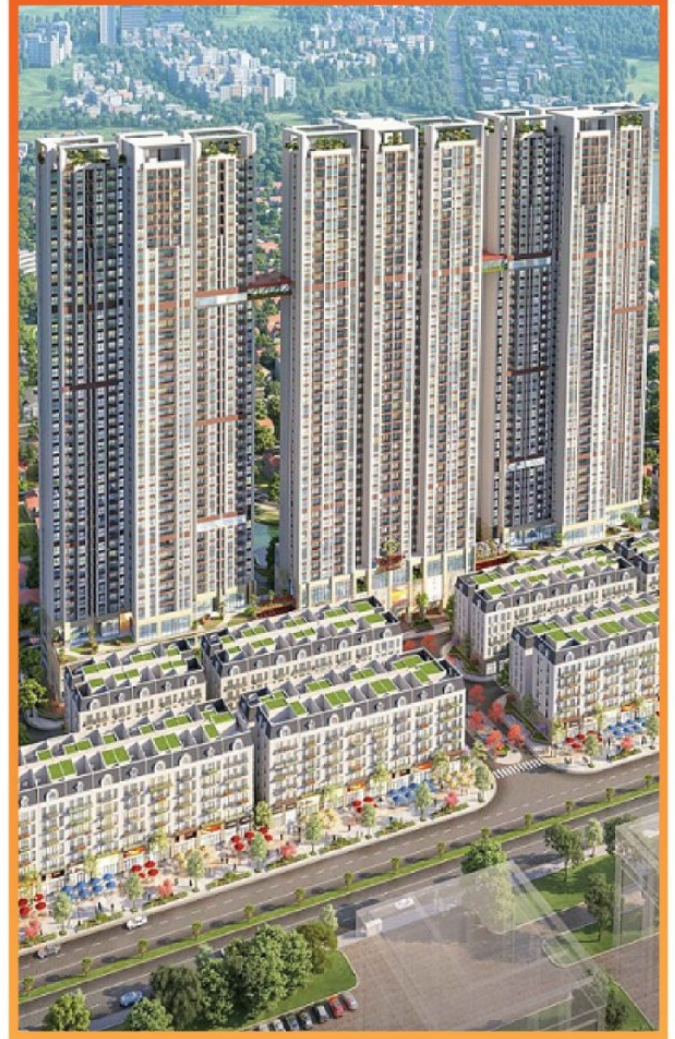
Dự Án Khu Đô Thị
